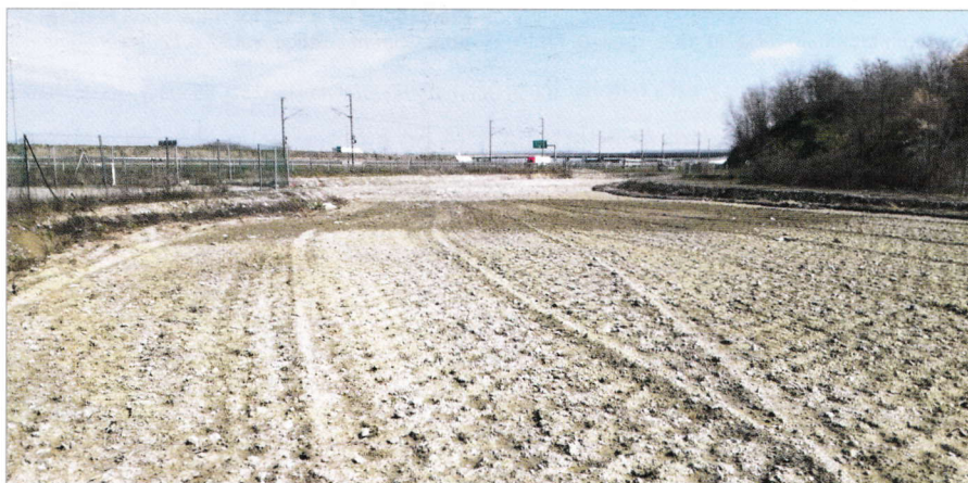
Foto 3 - Interventi di preparazione del sito ultimati.
